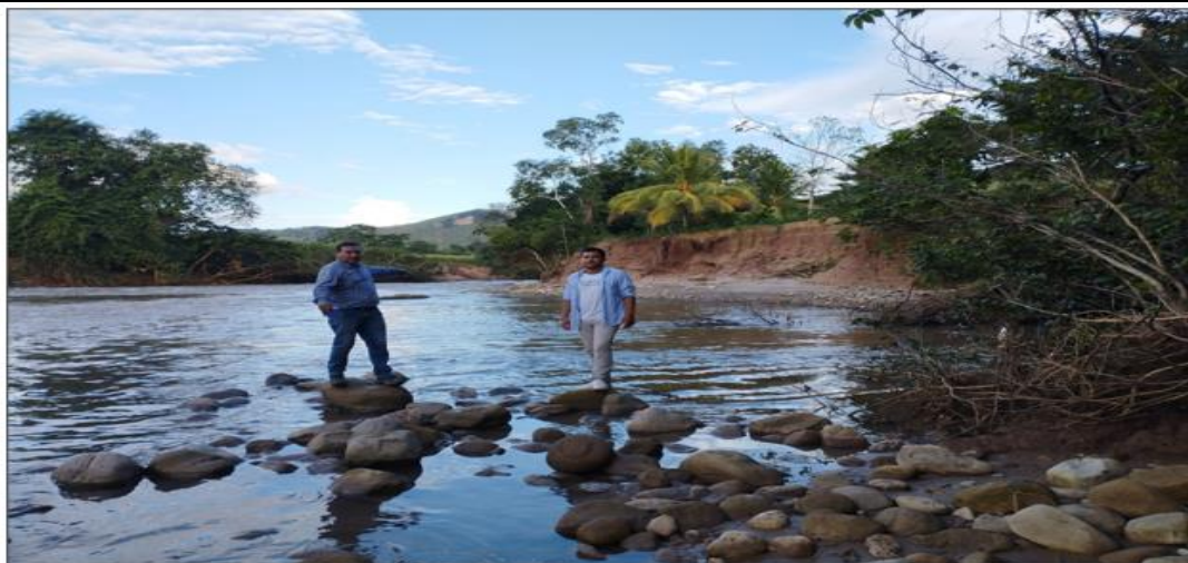
FIGURA N°01:TRAMO CRÍTICO EN EL RIO SISA, SECTOR AGUA BLANCA - LAGUNA DE OXIDACIÓN, DISTRITO DE AGUA BIANCA, DONDE SE OBSERVA TRAMO COLMATADO Y EROSION DE TALUD DE BORDOS DE LA RIBERA.
